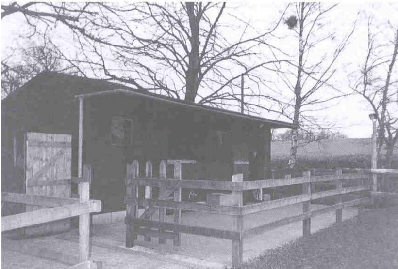
Fig. 8 Cobertizo con patio.
