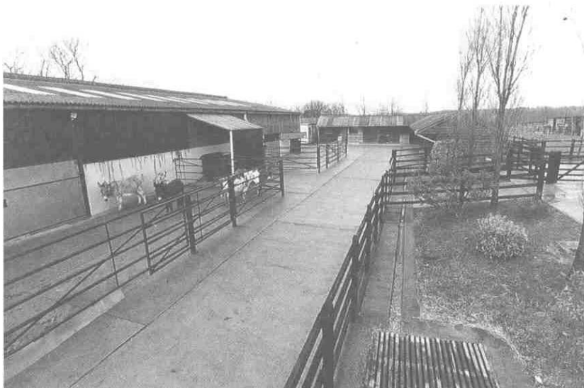
Fig. 7 Parte de la unidad de aislamiento en el Refugio de los Burros.
